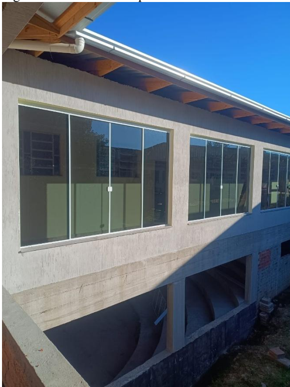
Figura 05 – Padrão de esquadrias de alumínio a serem seguidas.
